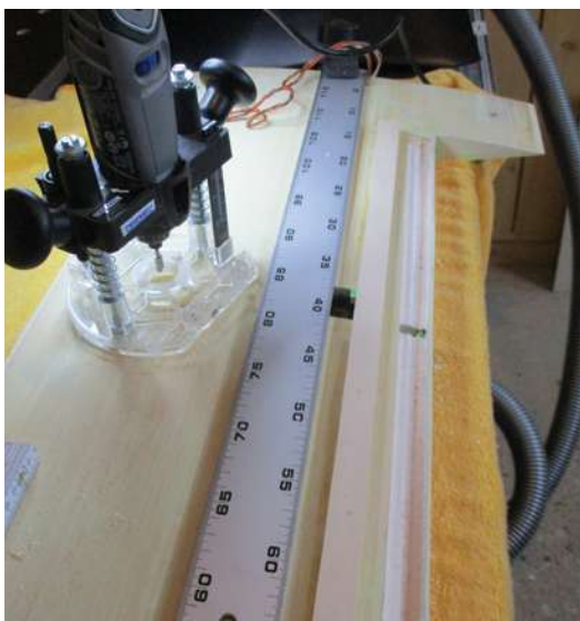
Um die Klappenscharniere sicherer befestigen zu können, wurde eine Nut gefräst und eine Sperrholzleiste eingearzt
